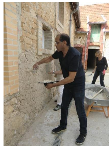
Stage enduits à la chaux (Source : PNR MR, 2015)
