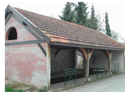
Lavoir dans la commune d'Avenay-Val-d'Or (Source : PNR MR)
