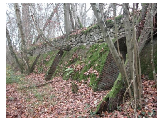
Briqueterie du Vertin (Source : PNR MR)
