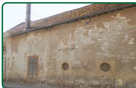
Construction en carreaux de terre, Ecuil.
