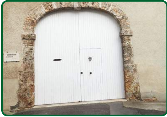
Porche en meulière grossièrement taillée, Ambonnay.
