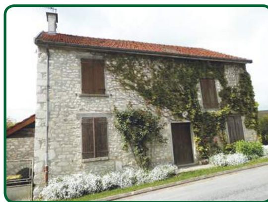
Construction en moellons calcaires, Jonquery.
