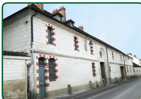
Construction en blocs de craie taillés, Mareuil-sur-Ay.
