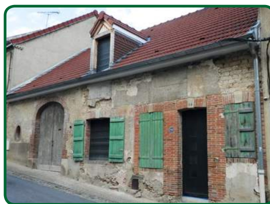
Constructions en carreaux de terre crue à Avenay-Val-d'Or et Ecueil.
