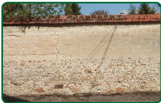
Mur en meulière et carreaux de terre.
