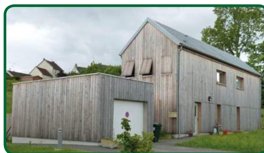
Logement et garage à Pargny-lès-Reims.
