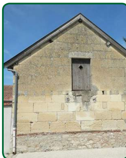
Construction en pierre de type Courville, Poilly.
