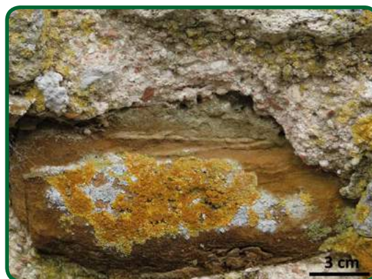
Moellon de grés ferrugineux en œuvre dans une maçonnerie.
