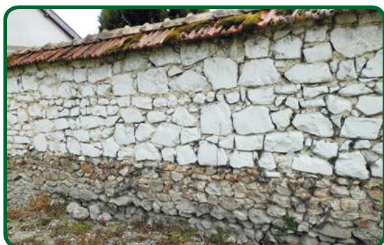
Mur en meulière et moellons de craie.
