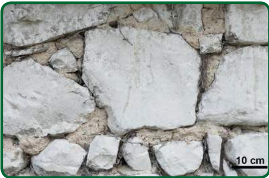
Moellons de craie maçonnés.
