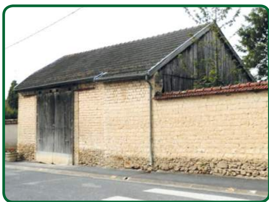
Bâtiment construit en carreaux de terre avec meulière en soubassement, Ambonnay.
