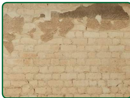
Carreaux de terre crue en œuvre, Bouzy.
