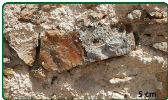
Meulière compacte en œuvre dans une maçonnerie.
